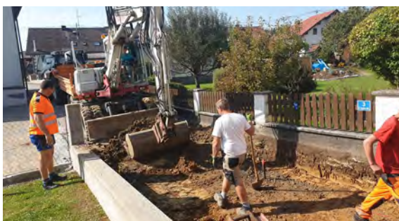
Sanierungsarbeiten bei der Alfred-Kubin-Straße
