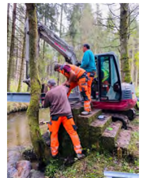
Arbeiten bei der Brücke am Freundorfer Steg
